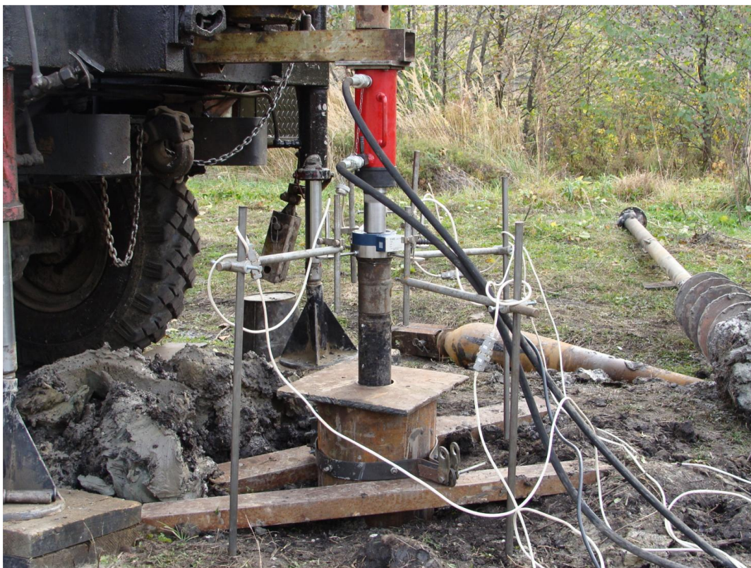
Рис. 7.6 Штамповые испытания грунтов в скважине винтовым штампом площадью 600 \text{ см}^2 с упором в станину буровой установки.
