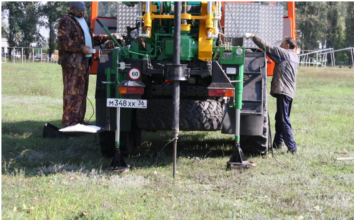
Рис. 9.1 Статическое зондирование с помощью гидравлической мачты самоходной буровой установки
